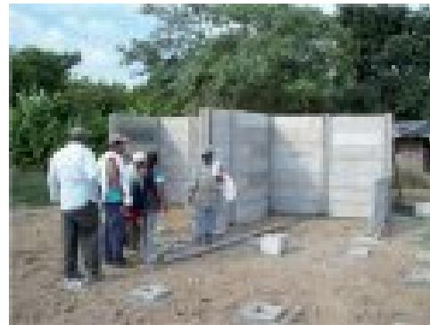
COLUMNAS Y MUROS PREFABRICADOS
