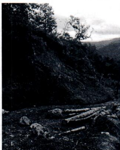
Fotografía 5: Deslizamiento menor sobre la vía
