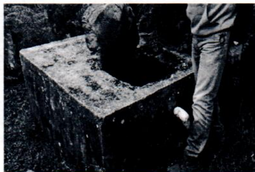
Fotografía 7: Acueducto atos alto
