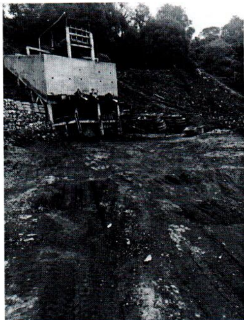
Fotografía 8: Patio de maniobras – Tolva E: 1177759 N:1299366
