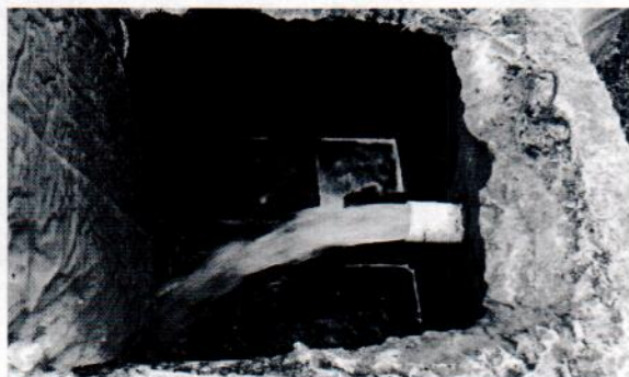
Fotografía 6: Acueducto atos alto
