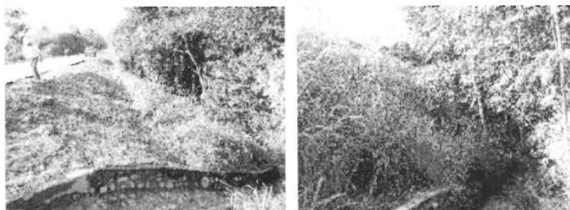
Fotografía No. 6 Áreas de box coulvert
