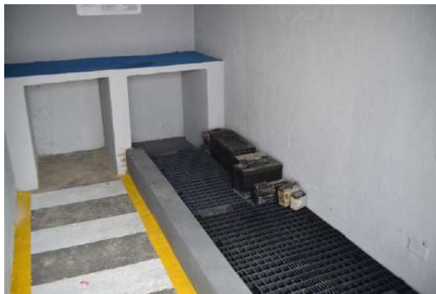
Disposición adecuada de baterías plomo-ácido usadas sobre bandejas con sistemas de retención de escurrimientos.
