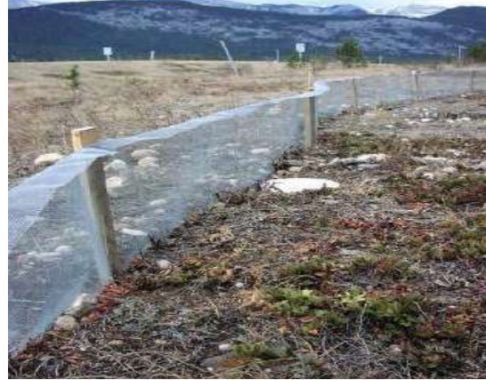
Figura 70: Barrera provisional para anfibios y reptiles.
