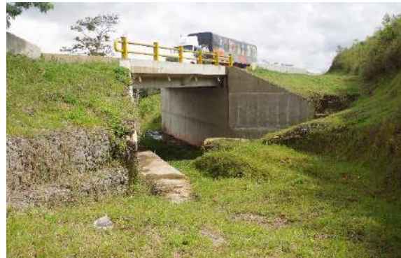
Figura 34: Pontón con paso de fauna en uno de sus lados.
