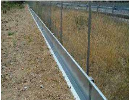
Figura 69: Estructura opaca de metal para guiar a la fauna más pequeña hacia el paso seguro.
