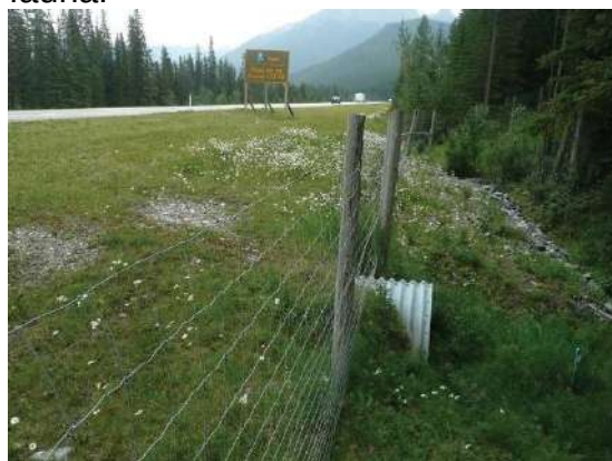
Figura 67: Barrera en cerco de alambre, sobre la entrada de una alcantarilla diseñada como paso de fauna.
