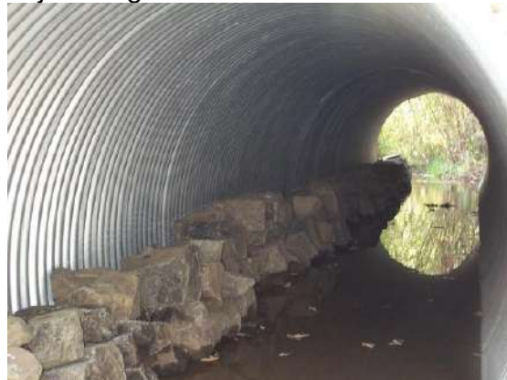
Figura 56: Hilera de piedras generar un paso seco en una alcantarilla con poco flujo de agua.
