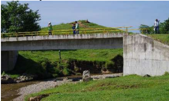
Figura 33: Puente con pilas fuera de la ronda, dejando libre el paso de fauna terrestre y sin intervención el cauce.
