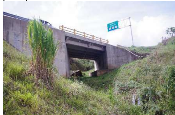
Figura 32: Pontón de uso exclusivo para paso de fauna.
