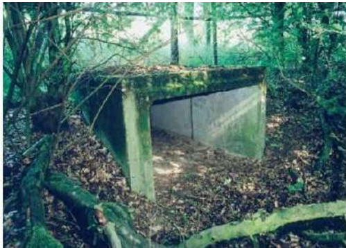
Figura 41: Box para fauna pequeña (ancho 1,2m, alto 0,8m, lago 40m.), en la carretera A50 en Holanda.
