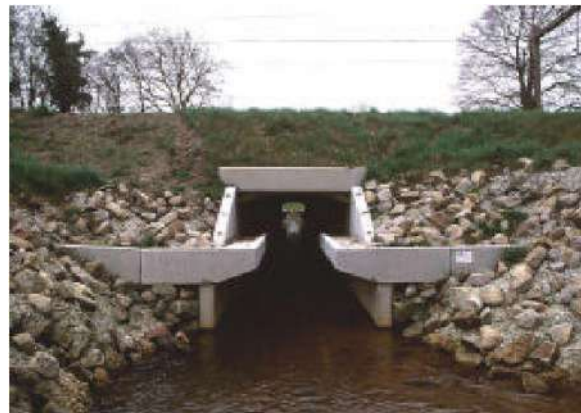
Figura 40: Box culvert con pasarelas a ambos lados.
