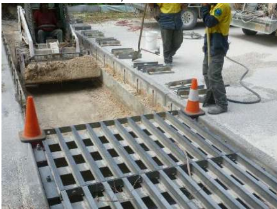
Figura 55: Mantenimiento de una alcantarilla superficial de gran tamaño, diseñada para paso de cangrejos en Christmas Island, Australia.
