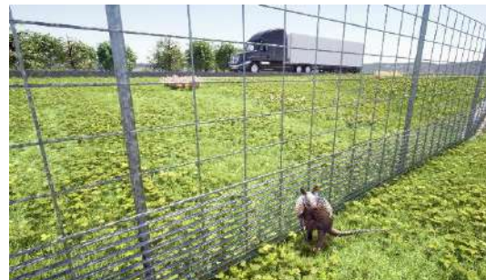
Figura 64: Detalle de la parte inferior de la barrera, con dispositivo antiescalada.
