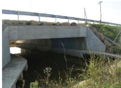
Figura 42: Box culvert con pasarelas a ambos lados.
