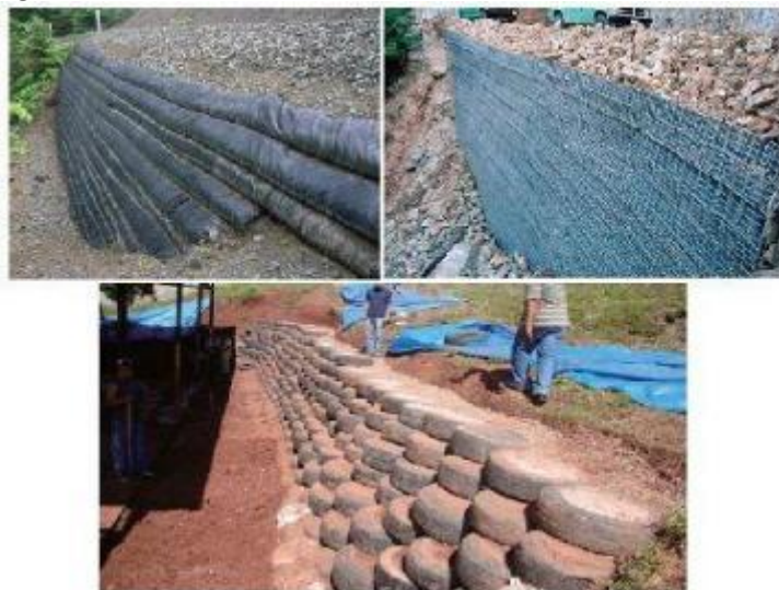
Fotografía 3 Muros de contención con diversos materiales.
