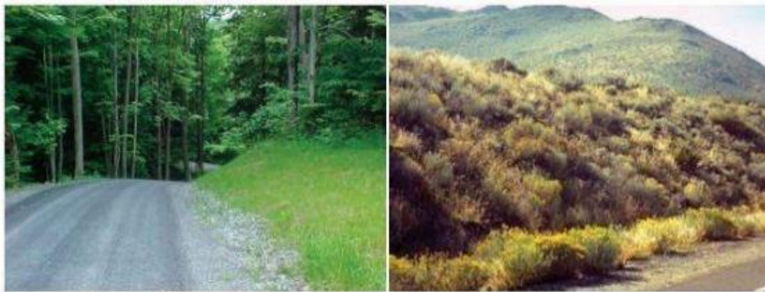
Fotografía 4 Taludes estabilizados con vegetación.
